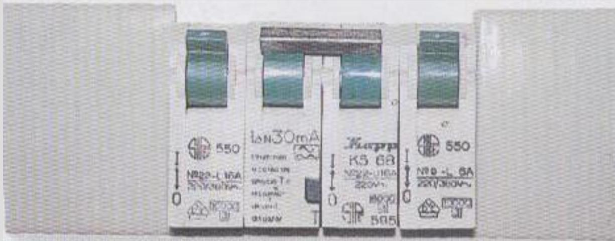
**Dispositivo automático que interrompe o circuito quando, a intensidade da corrente atinge valores demasiado elevados.**
