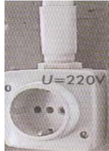
Nas nossas casas, a corrente elétrica da rede de distribuição não é corrente contínua, pois muda constantemente de sentido, chama-se **corrente alternada**.
