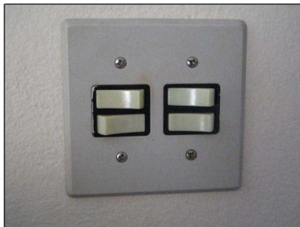
*Figura – Instalação embutida (Fonte: arquivo pessoal)*
