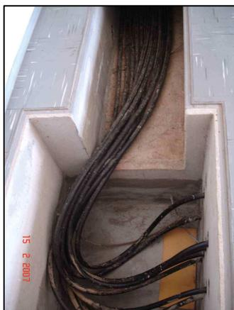
Somente cabos isolados especialmente com armação metálica podem ser enterrados diretamente no solo.
