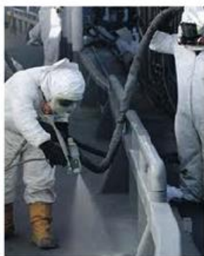
Jato de granalha
