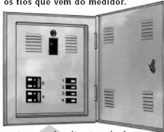
dele é que partem os circuitos terminais que vão alimentar diretamente as lâmpadas, tomadas e aparelhos elétricos.
