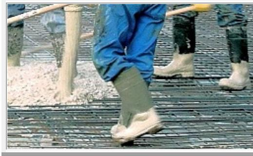
Estas armações são necessárias para atender à deficiência do concreto em resistir a esforços de tração (seu forte é a resistência à compressão) e são indispensáveis na execução de peças como vigas e lajes, por exemplo.
