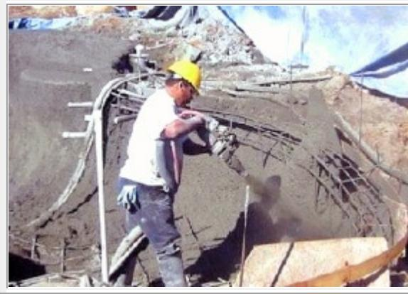
Este Concreto pode ser projetado por via-seca ou via-úmida, alterando desta forma a especificação do equipamento de aplicação e do traço que será utilizado.
