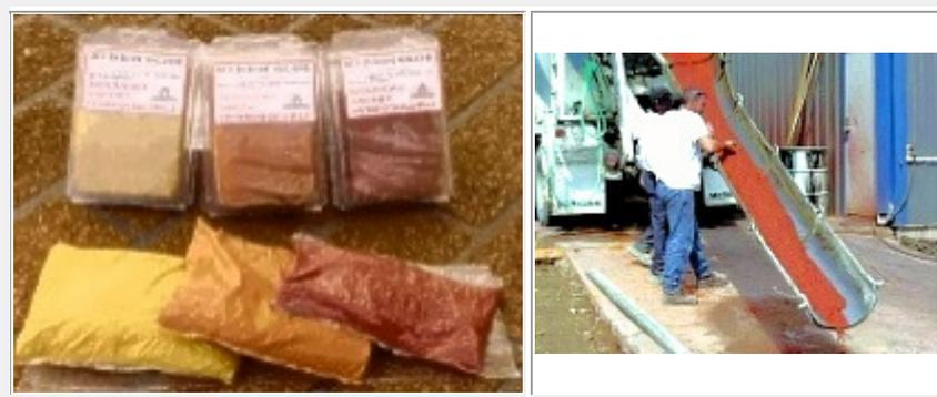
Suas cores são duráveis, mas para se ter um bom acabamento, é preciso ter cuidados com a vibração do concreto, com a qualidade das formas e no momento da retirada das mesmas.
