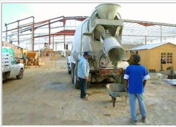
Independentemente da realização do teste de slump, devem ser colhidas amostras do concreto (corpos de prova), que no estado endurecido servirão para a realização de ensaios de resistência à compressão.
