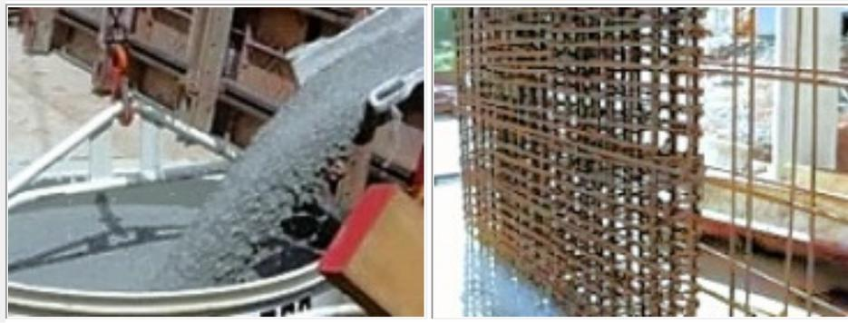
Sua característica é de fluir com facilidade dentro das formas, passando pelas armaduras e preenchendo os espaços sob o efeito de seu próprio peso, sem o uso de equipamento de vibração.
