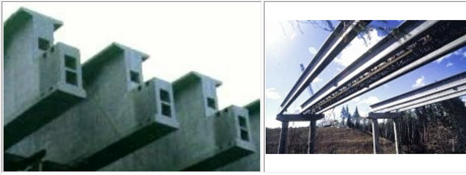
Ela pode ser definida como sendo o artifício de introduzir na estrutura, um estado prévio de tensões, através de uma compressão prévia na peça concretada (protensão).
