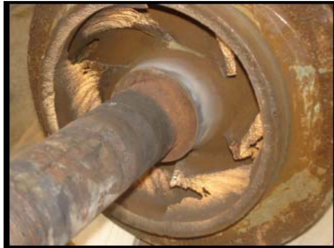
Figura 7.12 Cavitação em bomba no ano 2007
