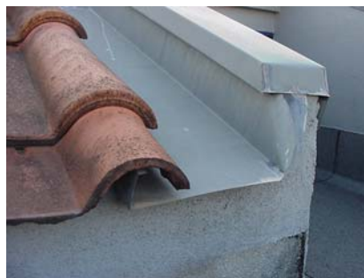
Fig.7 – Remate lateral em rufo de zinco
