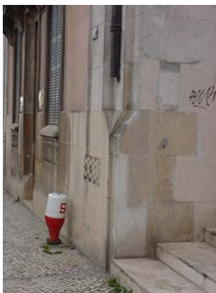
Fig. 18 – Entalhe da pedra para recepção e redireccionamento da água que escorre do tubo de queda.
