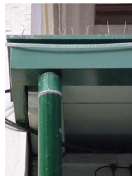
Fig.12 – Ligeira conexão direta caleira-tubo de queda
